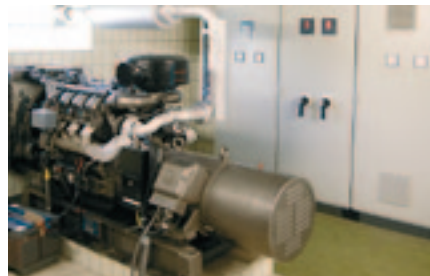
In der Mitte zwischen den beiden Tiefbrunnen liegt das Maschinenhaus, in dem sich die Schaltanlage und das Notstromaggregat (MWM D232 V8) befindet. Im Bild unten sieht man die Wasserentnahme im Brunnen.
