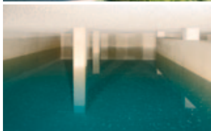
Der Abtropfputz an der Deckenuntersicht des Hochbehälters schützt vor Verunreinigung des Wassers
